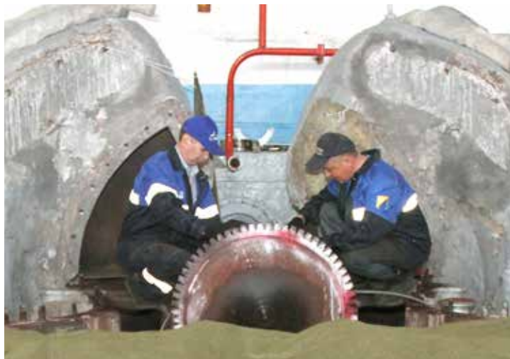
Идет проверка зазоров перед установкой ротора двигателя
