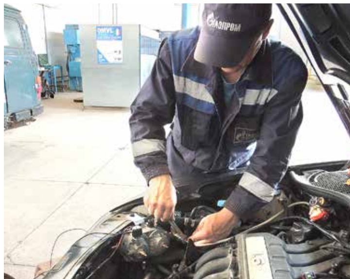
Установка комплекта ГБО в моторное отделение автомобиля
